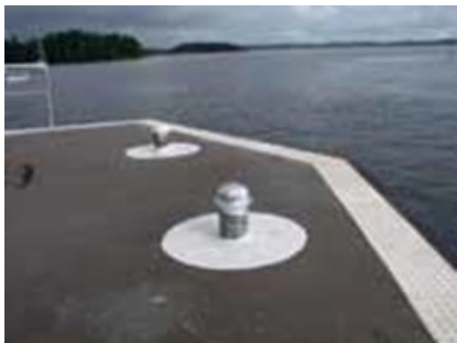
Kontrastmarkering av pollare och bryggslut.
