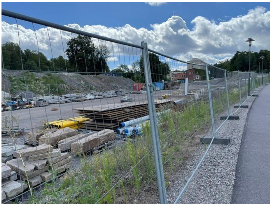
Figur 14. Befintlig upplagsyta vid Albano, planerat arbetsområde.
