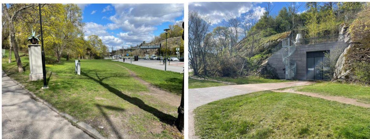
Figur 21. Platsen för Arbetsområde Bellevue (till vänster). Befintlig tunnelmynning vid Bellevue (till höger).
