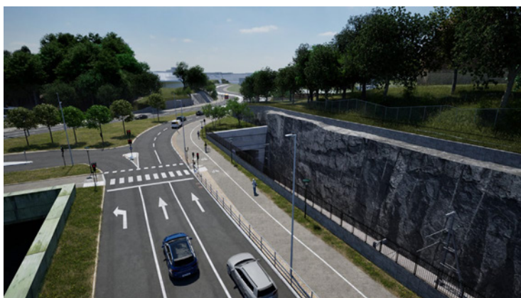
Figur 3-16 Till vänster nedfart Norra Länken och till höger tunnelmynningen.
