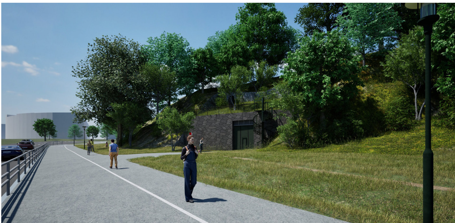
Figur 3-40 Porten till service- och arbetstunneln sedd från norr.
