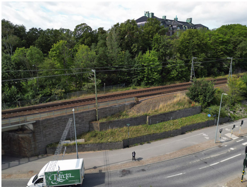
Figur 2-5 Fotot visar järnvägsbrons norra landfäste och granitmurarna som tar upp höjdskillnaden ner mot gång- och cykelvägen längs Roslagsvägen.
