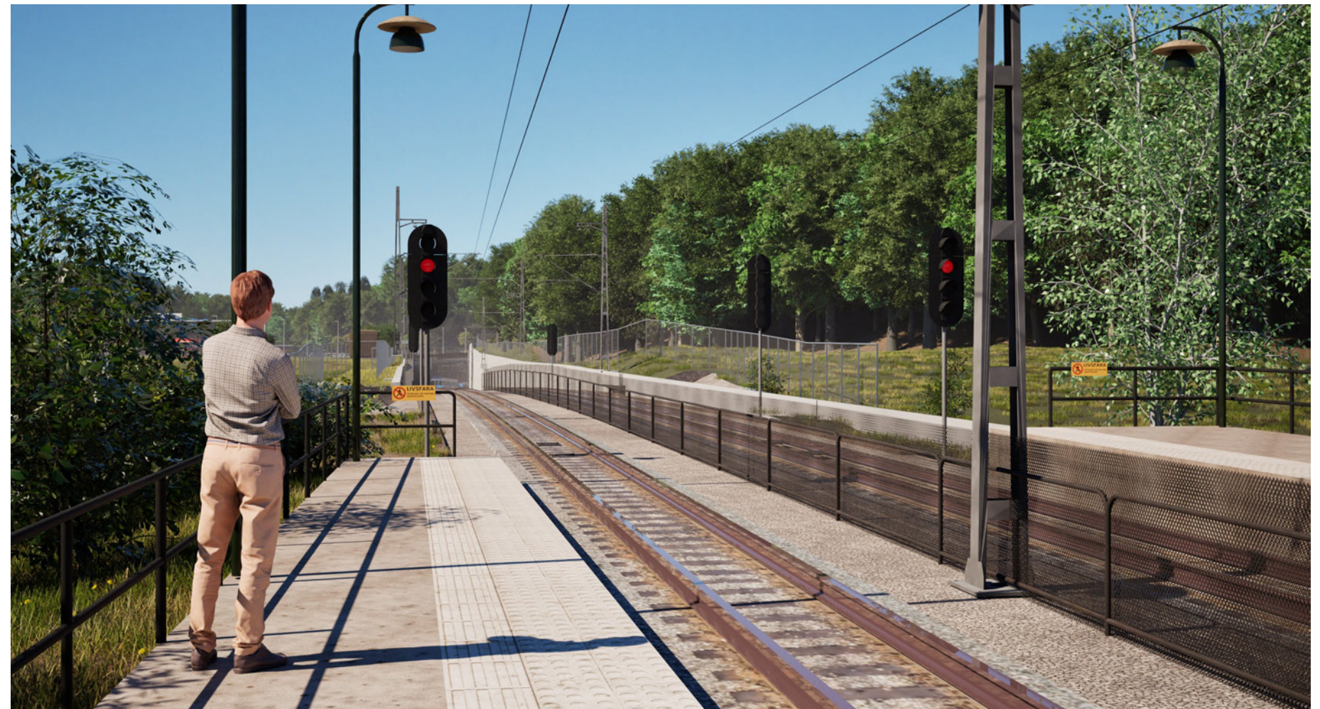
Figur 3-10 Ny Vy 2 från plattformens södra ände vid Universitetets station. Spåret sjunker och väggarna blir höga mot insidan av tråget.
