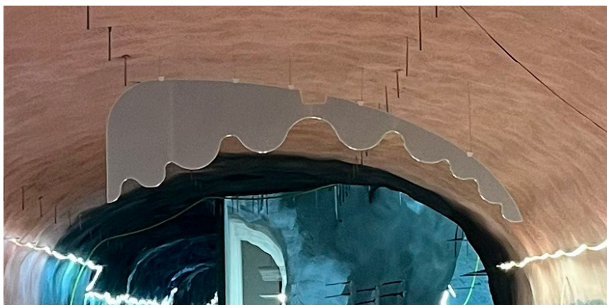
Figur 4-59 Referens vertikal akustikpanel från station Hagastaden.
