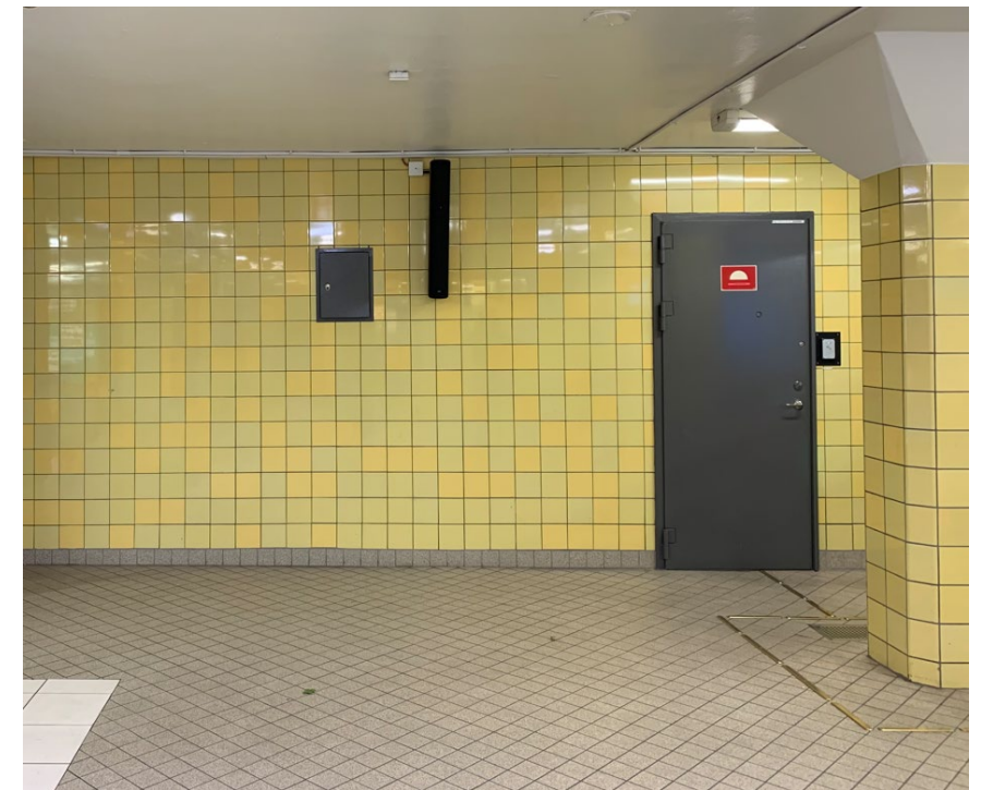
Figur 4-20 Referens kakel i tunnelbanestation Rådmanngatan.
