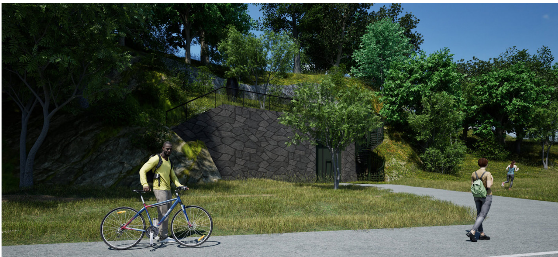
Figur 3-39 Porten till service- och arbetstunneln sedd från sydost.
