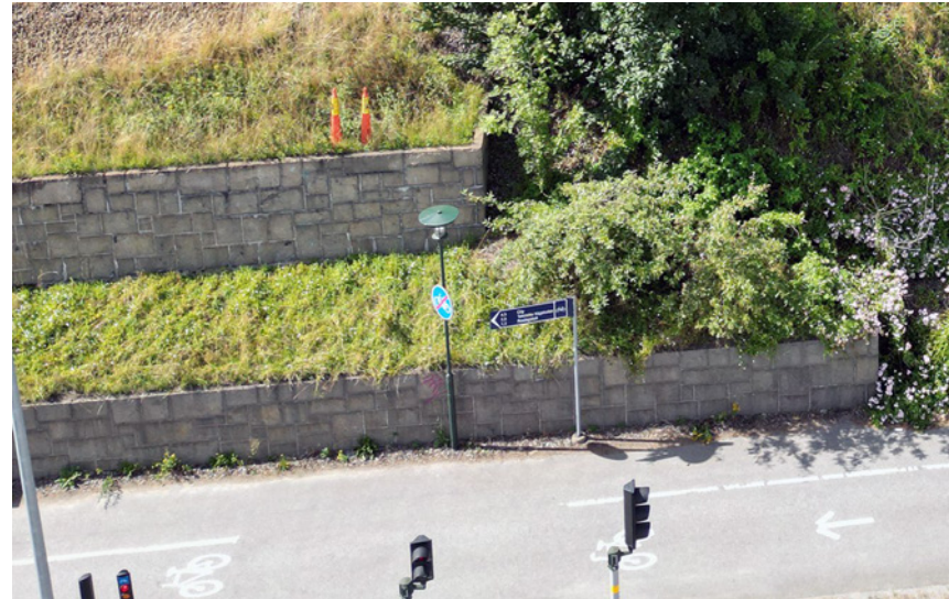
Figur 3-26 Befintliga stödmurar utmed banvallen. De hänger samman med brofästet. Den befintliga belysningen är målad i Stockholmsgrönt.
