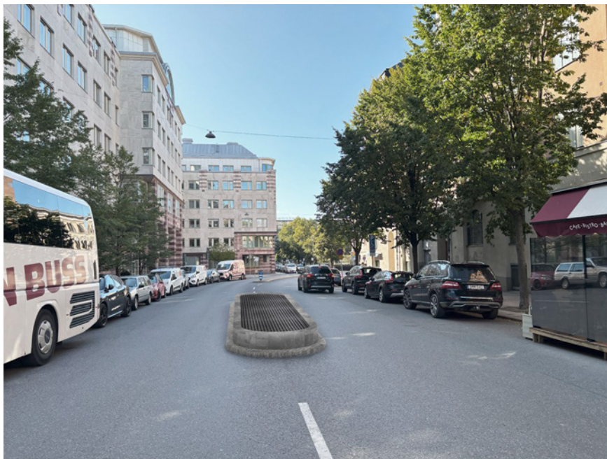
Figur 4-76 Illustration brandgas- och luftutbytesschakt Olof Palmes gata.
