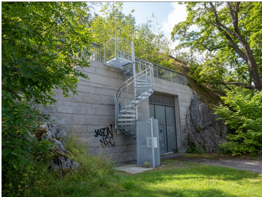
Figur 2-11 Portväggen är väl inpassad mot berget. Fasaden består av beklädnadssten i granit.
