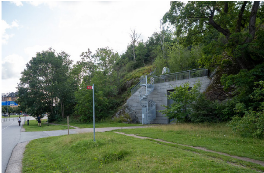
Figur 2-9 Intill Roslagsvägen vid Bellevue ligger port och mynning till servicetunneln för en av SVOA:s dagvattenledningar. En trappa leder upp till takets ventilationshuvar. På taket växer småträd och lägre vegetation.
