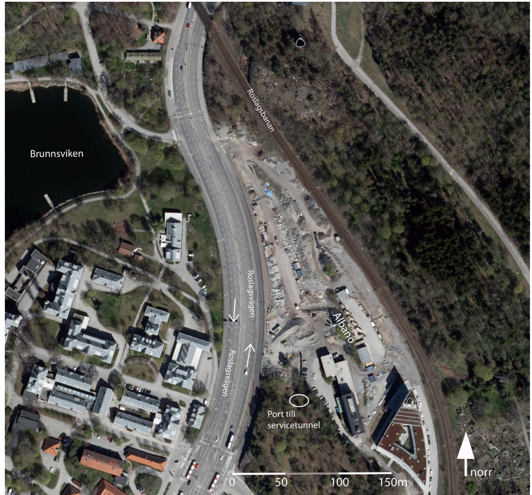
Figur 2-8 Vid Albano finns idag en igensatt mynning till arbetstunneln för Norra länken.
