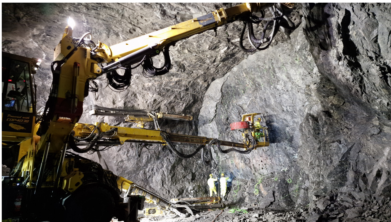
Tunnellarbeten för nya tunnelbanan i Högdalen.
