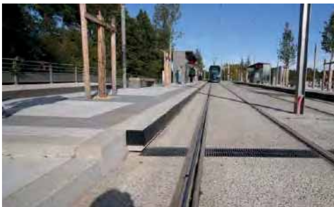
Markbetong i gång- och cykelpassager samt hållplatslägen
