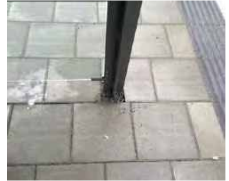
Fundament döljs under marknivå
