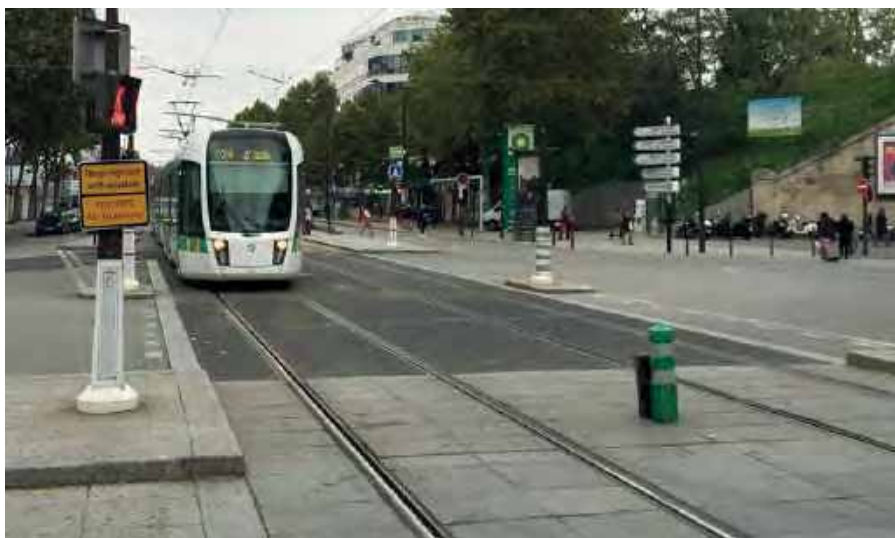
Gatukorsning över spårområde markerad med avvikande material och genomgående ramsten
