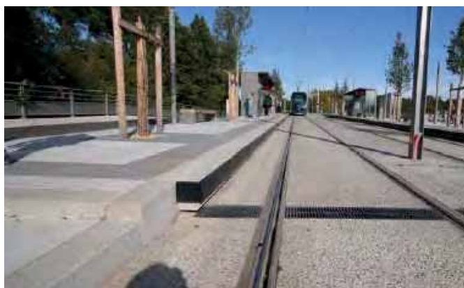
Markbetong i gång- och cykelpassager samt hållplatslägen
