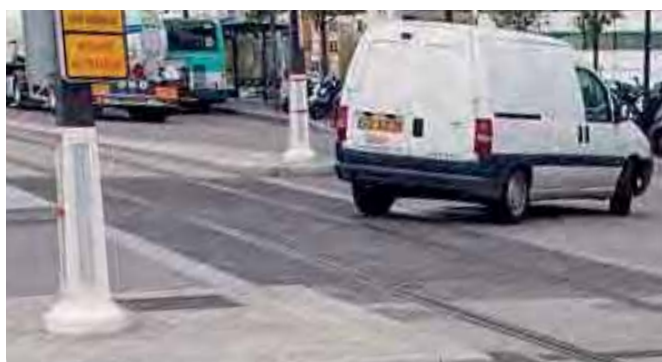
Markbetong med kontrasterande kulör mot omgivande beläggning används i gatukorsningar
