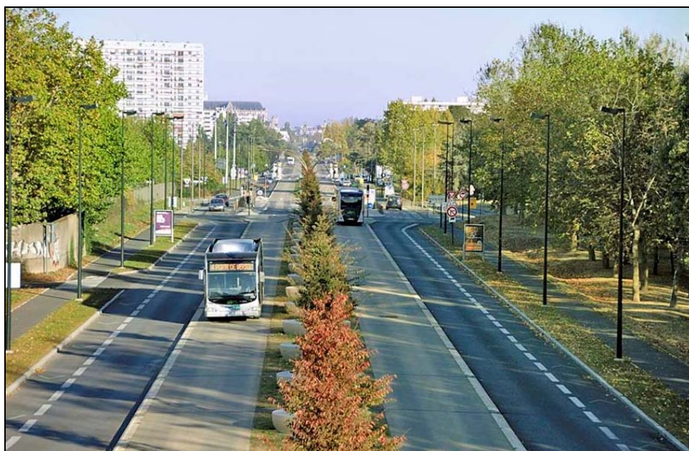
Figur 13 Visar ett exempel på ett BRT-system. Busway Nantes, Frankrike
