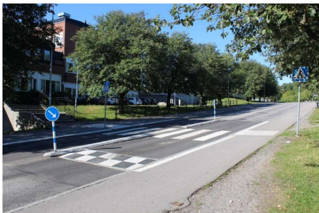
Figur 19 Exempel på upphöjd tillfart kombinerad med övergångsställe.
