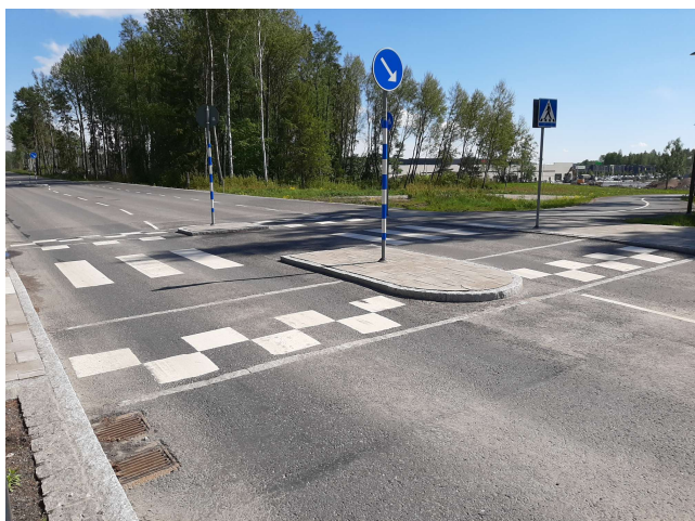
Figur 20 Exempel på platågupp.
