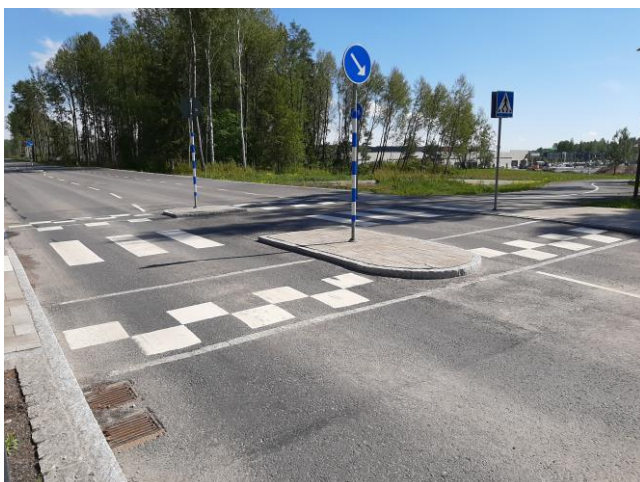
Figur 20 Exempel på platågupp
